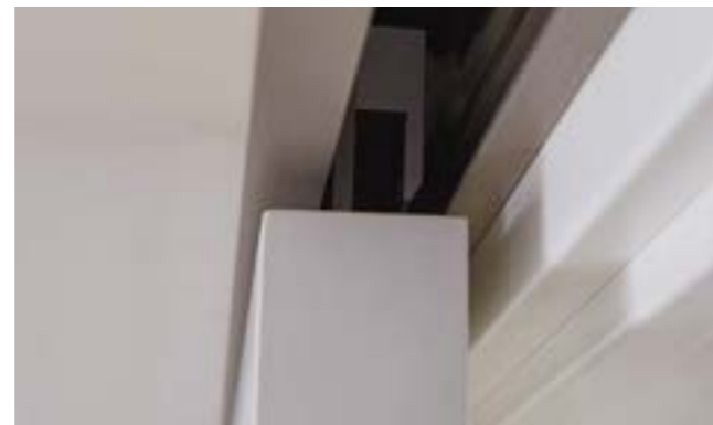
Befestigung einer Holztür im Schiebetürbeschlag LINE
