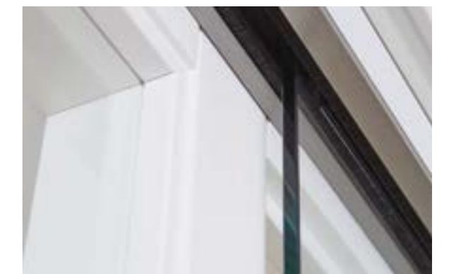
Befestigung einer Ganzglastür im Schiebetürbeschlag LINE
